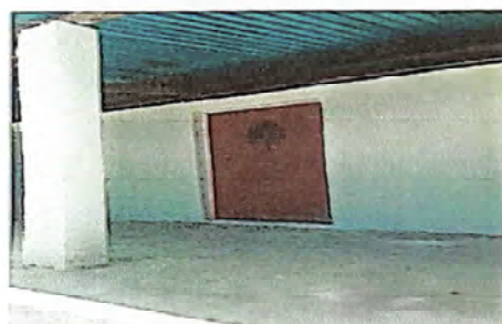
Foto 4: Así finaliza el acado del repello y cernido de los paredes de la cocina escolar del establecimiento educativo.
