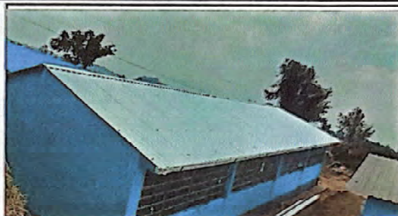
Foto 2: Así finaliza la construcción del techado los edificios escolares de la Escuela Oficial Rural Mixta Aldea Piedra de Fuego.
